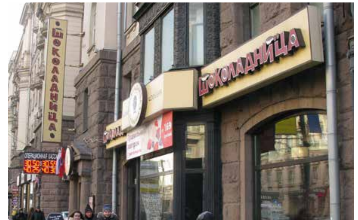
За вывесками плохо видно дом, на котором они установлены. Панель-кронштейн закрывает вид и на следующий дом
