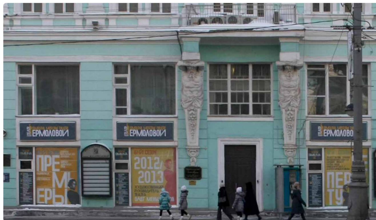
Заклеенные окна допустимы, только если в здании ведутся ремонтные работы
