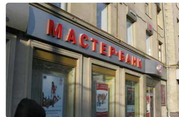
Декоративная панель портит внешний вид ухоженного фасада и нарушает пластику здания
