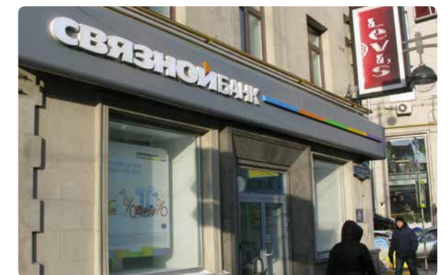
Декоративная панель нарушает пластику здания и частично перекрывает архитектурные детали фасада
